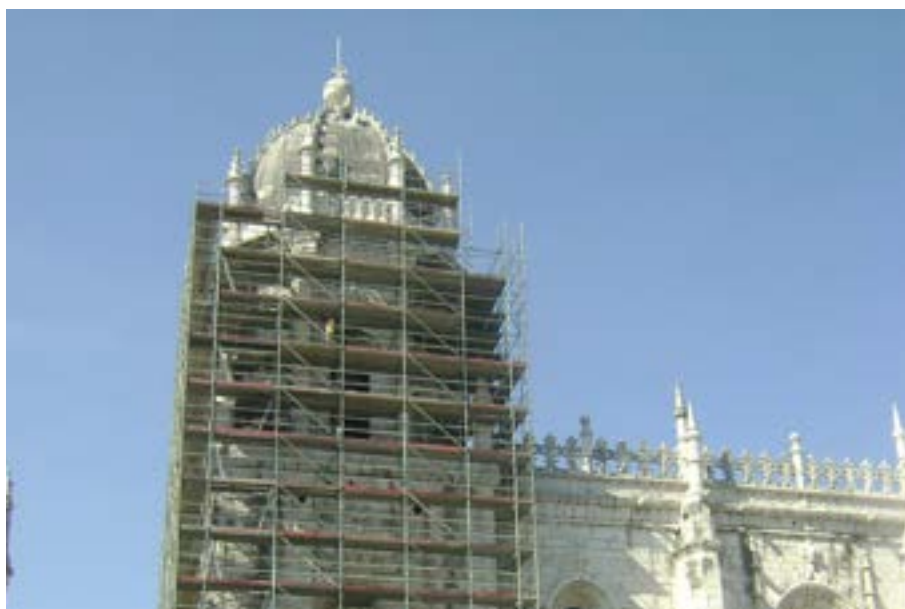
Imagem 89 – Ação de conservação de património edificado
