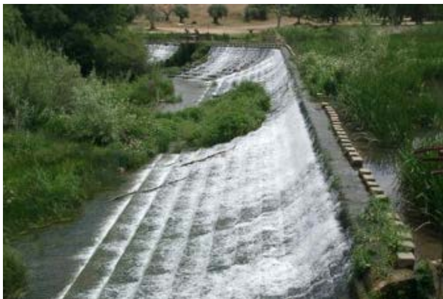
Imagem 104 – Açude da Fábrica de Fiação de Tomar
