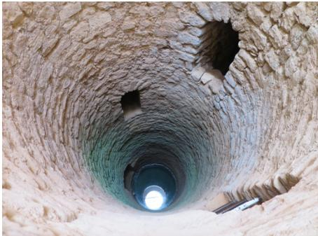
O poço-cisterna captava água dos níveis freáticos, abastecendo a parte alta da cidade. Trata-se de uma estrutura escavada no substrato geológico, que atinge 18 m de profundidade. O espaço central é rodeado por galeria em espiral, formada por escadaria que permitia o acesso à água.
